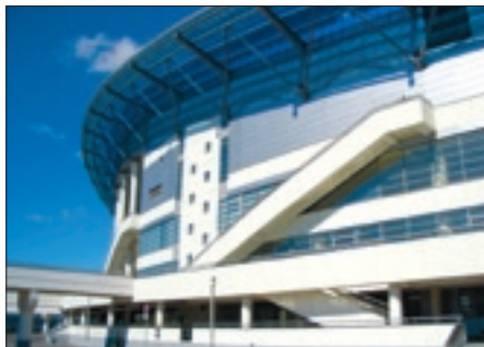
Крытый конькобежный стадион в Крылатском (подрядчик ЗАО «Риком»)
